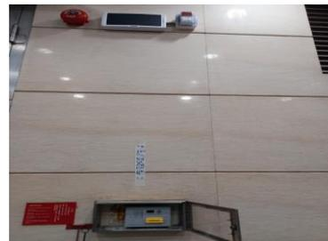
2.12 供應及更換 3 區 FM200 放氟系統控制箱及有關配件，並接駁原有的線路、調整及測試系統至正常運作；現行牌子：Hochiki 及型號：K11031M2（供 D 變電站（03321-3）、E 變電站(03322-9)）；（2 單）
