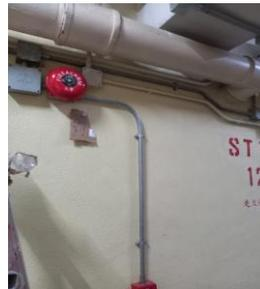
3.2.3 新做消防掣手及警鐘包括約 4 米長內線路，並接駁現有線路·共 9 單
