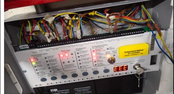
2.13 供應及安裝新裝 3 區 FM200 放氟系統控制箱內 12V, 7Ah 電池 x2 件及有關配件；（供 D 變電站（03321-3）·E 變電站（03322-9））；（2 單）
