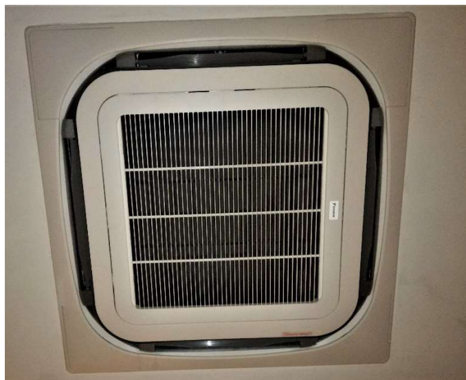
安裝後室內機
