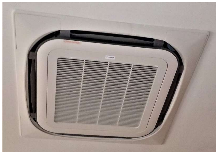
安裝後室內機
