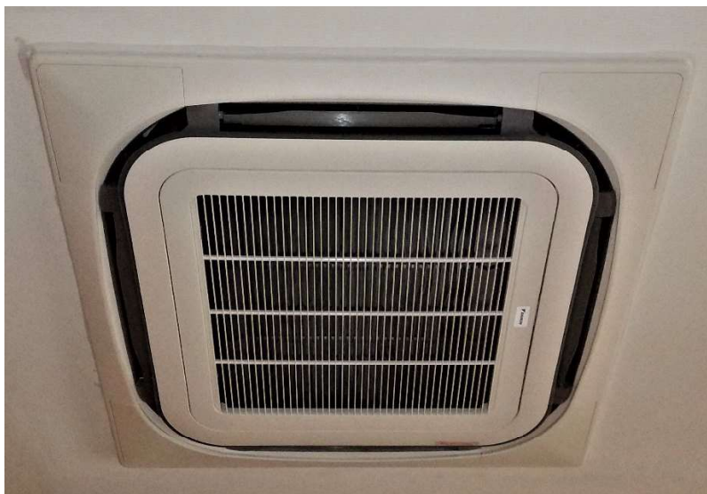
安裝後室內機
