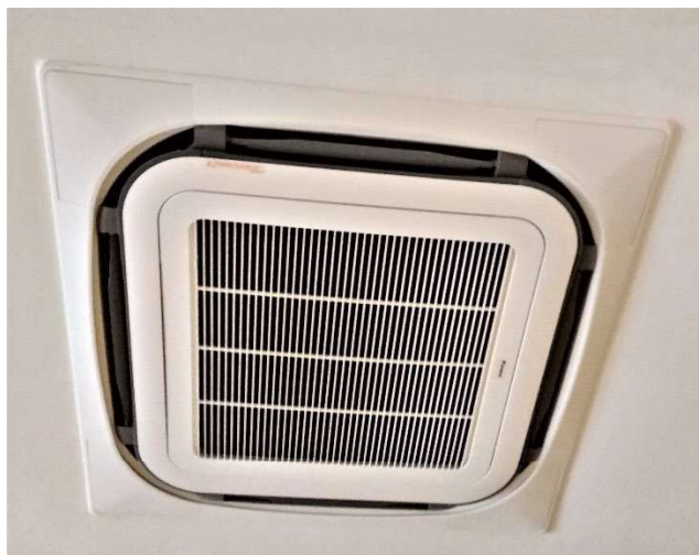
安裝後室內機
