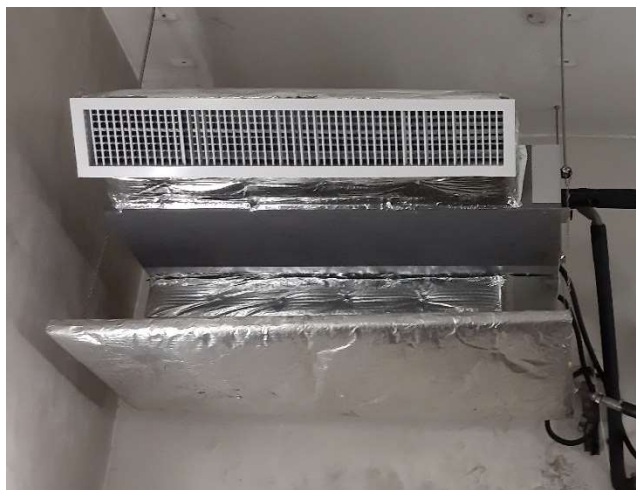
安裝後室內機
