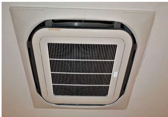
安裝後室內機
