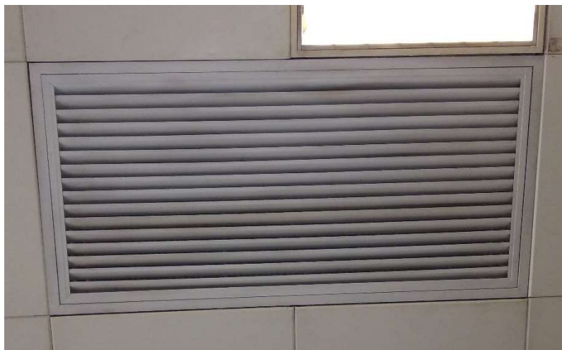
安裝後室內機
