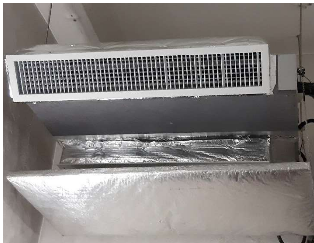
安裝後室內機
