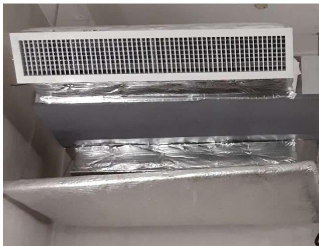
安裝後室內機
