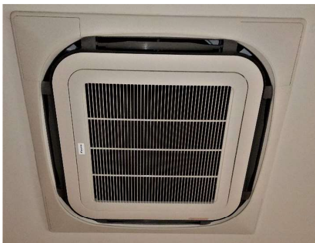
安裝後室內機
