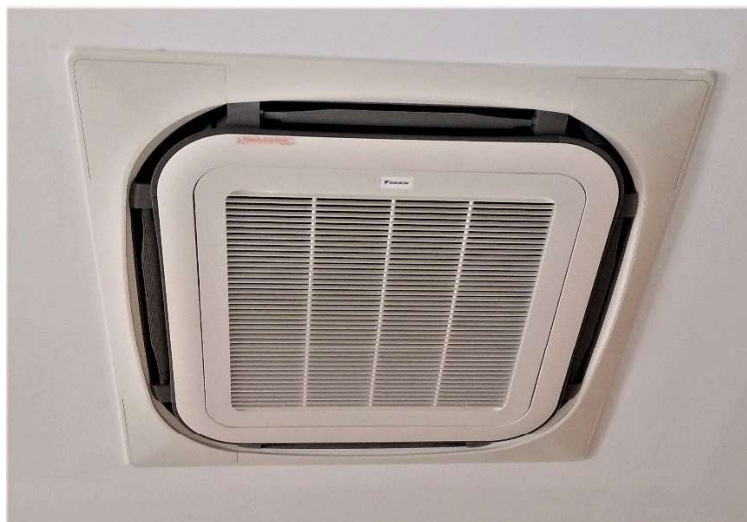
安裝後室內機
