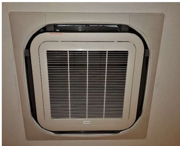
安裝後室內機
