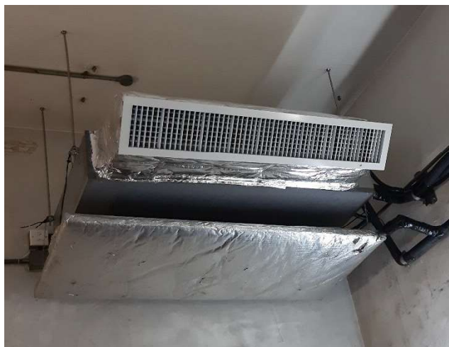
安裝後室內機
