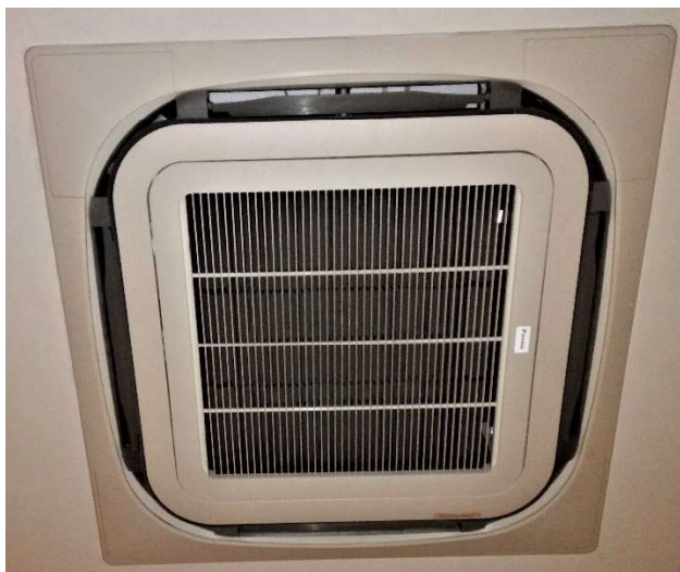
安裝後室內機
