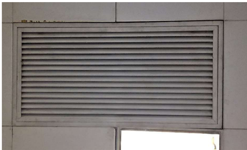
安裝後室內機
