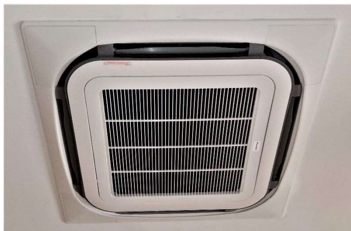
安裝後室內機
