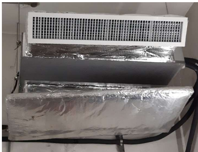
安裝後室內機
