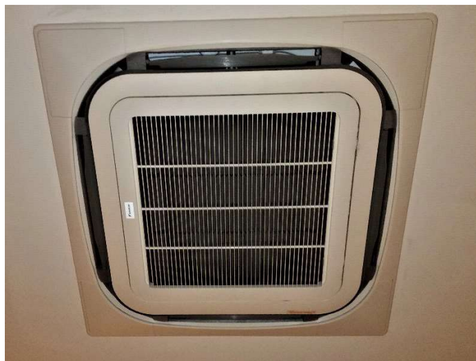
安裝後室內機
